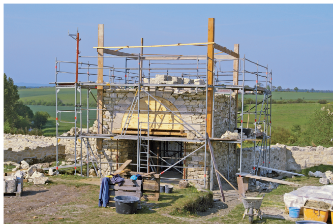
Abb. 9. Werla, Tor II: Aufmauern von Wehrmauer, Torflanken und Torturm (Foto: M. C. Blaich, 2012).
