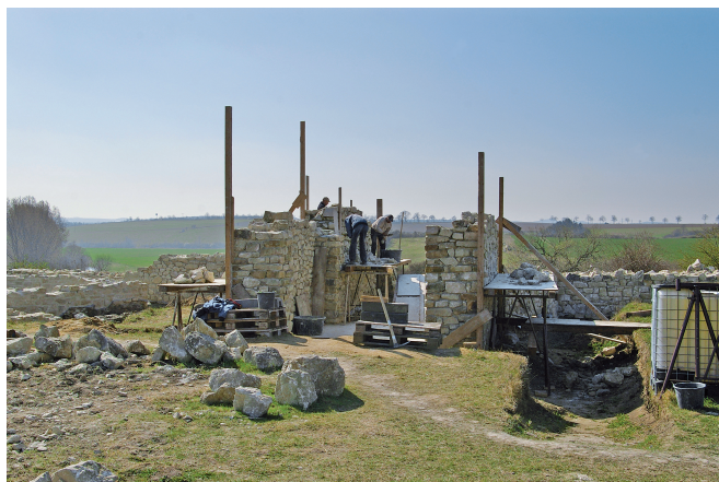
Abb. 9. Werla, Tor II: Aufmauern von Wehrmauer, Torflanken und Torturm (Foto: M. C. Blaich, 2012).
