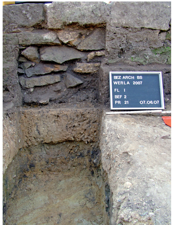
Abb. 5. Werla, Tor II: Deutlich zu erkennen ist das unterschiedliche Gefüge von Fundament (Bruchstein in Lehm) und aufgehendem Mauerwerk (Kalkstein in Kalkmörtel) (Foto: H. Meyer, 2007).
