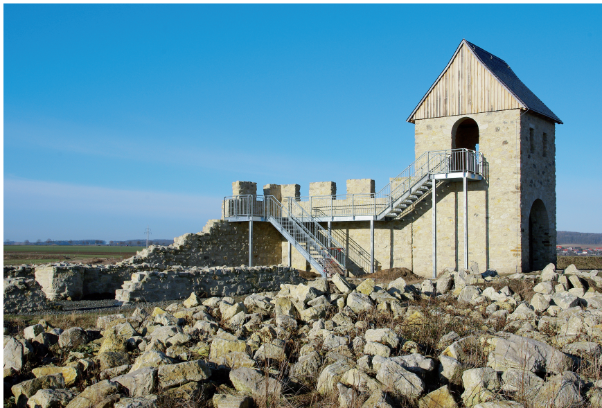
Abb. 13. Werla, Tor II: Blick von innen auf die fertiggestellte Wehrmauer mit dem Aufgang in das Obergeschoss (Foto: Henning Meyer, 2013).
