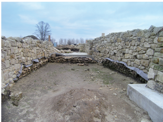
Abb. 8. Werla, Tor II: Blick von außen auf die Wehrmauer, deren Fundament aus statischen Gründen eine Betonflanke vorgesetzt wurde (Foto: M. Geschwinde, 2012).
