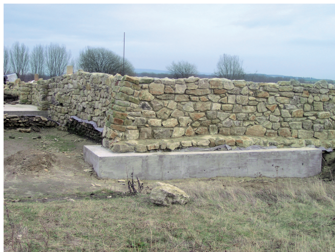
Abb. 8. Werla, Tor II: Blick von außen auf die Wehrmauer, deren Fundament aus statischen Gründen eine Betonflanke vorgesetzt wurde (Foto: M. Geschwinde, 2012).
