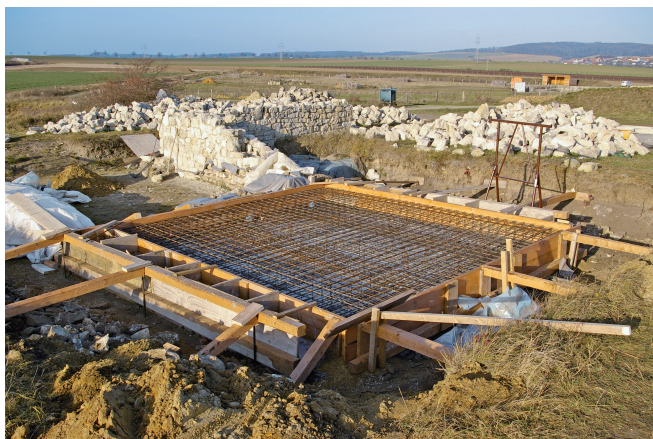
Abb. 6. Werla, Tor II: Einbau des Stützfundaments in die hintere Torkammer (Foto: M. C. Blaich, 2012).
