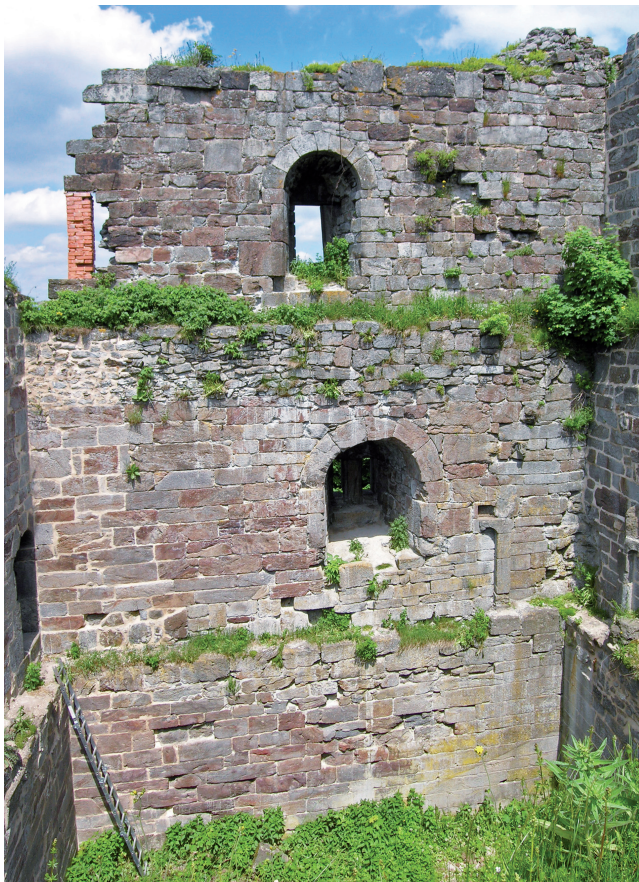
Abb. 6. Přimda, Burg. Donjon, innere Nordwand. Im ersten Obergeschoss (in der Mitte) rechts Eckkaminreste (Foto: Verf., 2008).
