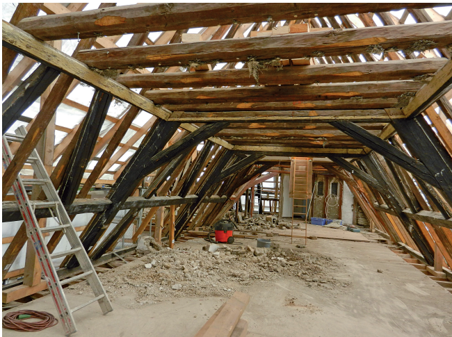
Abb. 12. Dachstuhl des Ostflügels.
