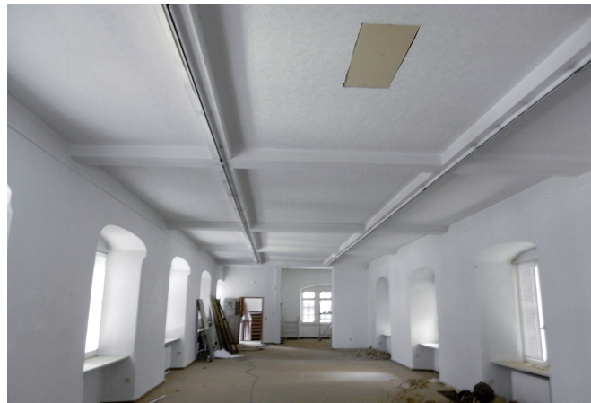
Abb. 13. Bestehende Stahlverstärkungen der Decke über dem Obergeschoss im Ostflügel.
