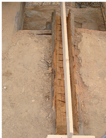
Abb. 14. Ostflügel, ausgehöhlter Deckenbalken der Kölner Decke.
