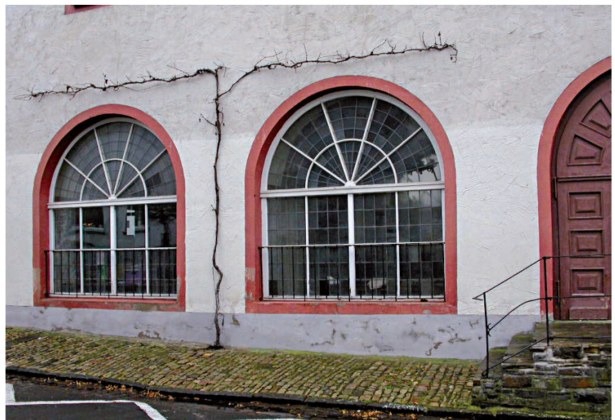
Abb. 1. Erneuerter Putz und Farbauffrischung im dauerbelasteten und geschädigten Sockelbereich (Foto: Verf.).
