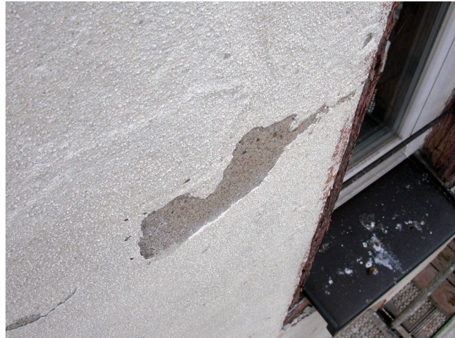
Abb. 3. Vom Unterputz abgelöster Glättputz am Bergfried (Foto: Verf.).
