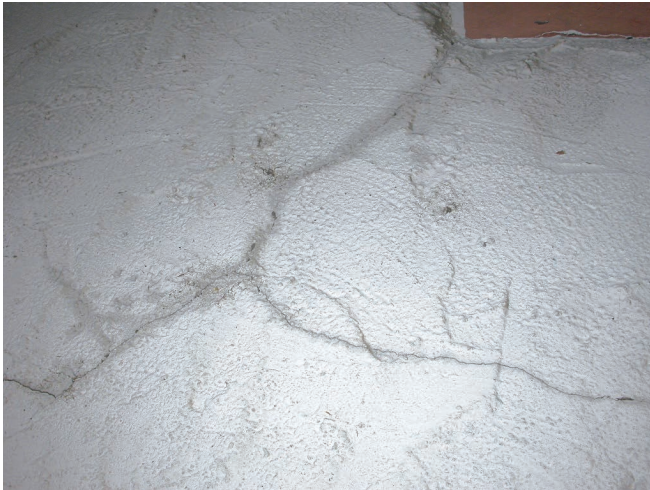
Abb. 2. Spannungsrisse im jüngeren Putzaufbau des Bergfrieds (Foto: Verf.).
