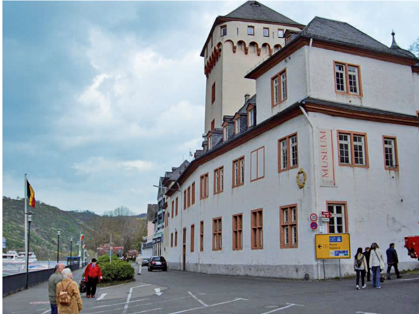
Abb. 1. Kurfürstliche Burg Boppard am Rhein vor der Sanierung (Foto: Verf.).
