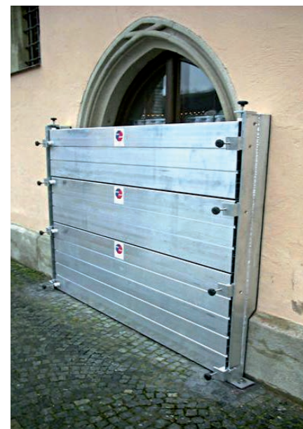
Abb. 4. Beispiel für einen realisierten Türverschluss mit mobilen Elementen: Eingangstür Schutzhöhe und Breite 1,80 m (Foto: Verf.).
