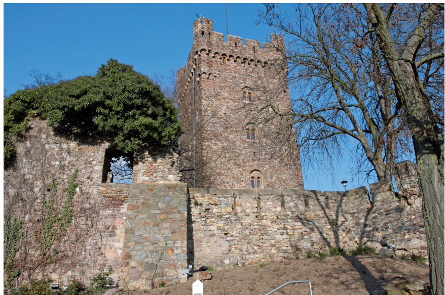
Abb. 7. Südliche Ringmauer, Feldseite. Rechts des Stützpfilers der Übergang von mittelalterlichem zum historistischem Mauerwerk des 19. Jahrhunderts (Zeichnung: Verf.).
