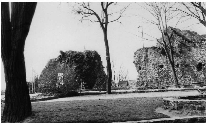
Abb. 8. Südliche Ringmauer, Hofseite. Undatierte Fotografie der ersten Hälfte des 20. Jahrhunderts. Rechts oben im Bild: Noch freiliegendes Mauerwerk mit originalen Treppenstufen auf der Innenseite des spitzen Mauerfragments (Foto: Stadtarchiv Bingen).
