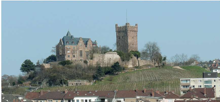
Abb. 1. Ansicht von Süden mit Originalsubstanz im Bereich der südlichen Ringmauer (Foto: Verf.).
