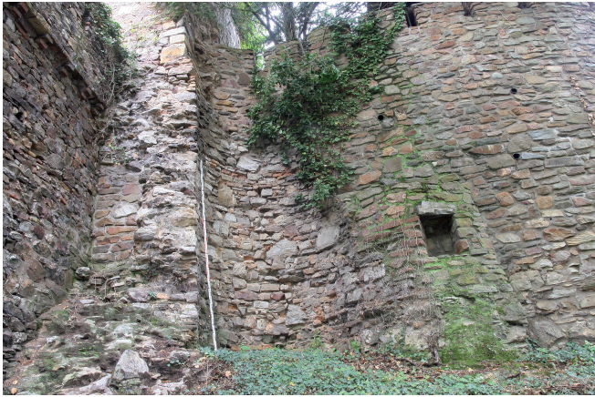
Abb. 5. Fragment des Rundturms nördlich der heutigen Brücke. Auf der südlichen Seite befindet sich ein fast identischer Befund, ein zweiter Turm. Die Brücke sitzt teilweise auf dem Turmstumpf auf (Foto: Verf.).
