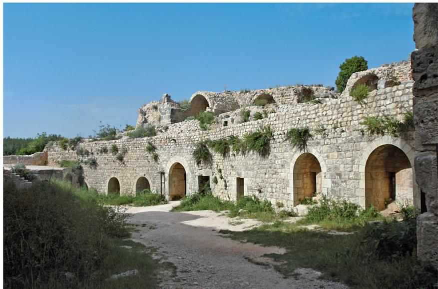
Abb. 18. Burg Sahyun (Saône, Castel Saladin), Syrien. Innenflucht der Stirnwandmauer aus dem Jahre 1120 mit Doppelschießschartenkammern (Foto: Verf.).
