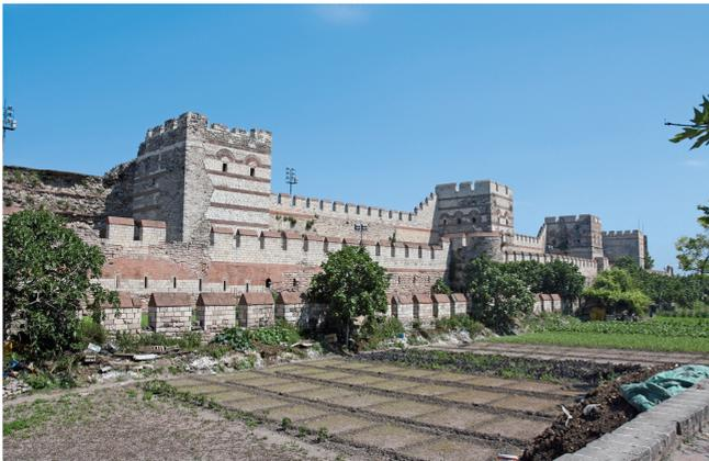
Abb. 11. Konstantinopel (Istanbul), Türkei. Theodosianische Befestigung. Oben oktogonaler Turm der Hauptmauer, unten quadratische Türme der Hauptmauer in unglücklicher moderner (zum Glück nicht mehr weitergeführter) denkmalpflegerischer Sanierung (Foto: Verf.).
