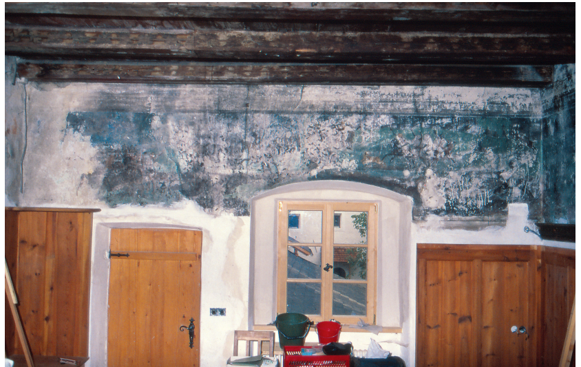
Abb. 13. Nordwestturm, Raum im ersten Obergeschoss, Nordwand und Decke, Zustand 2001 mit bereits erneuertem hölzernen Sockel.
