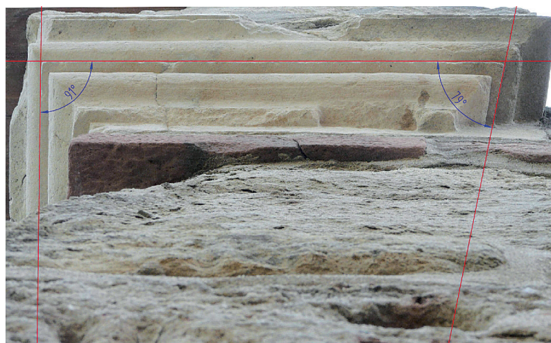
Abb. 3. Ingelheim, Aula regia, Kämpfer des Apsispfeilers in Untersicht mit eingetragenen Winkeln (Foto Verf.).
