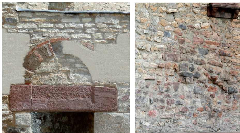
Abb. 13. Ingelheim, Pfalz, Mauerwerksgefüge.
