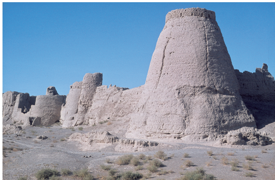
Abb. 8. Wehrmauer mit Türmen und Bastei der Festung Qala-i Kash.
