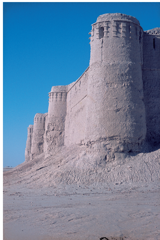
Abb. 12. Die Wehrmauer von Qala-i Naw mit reduzierten Basteien als Flankenschutz der überhöhten Kurtinen.
