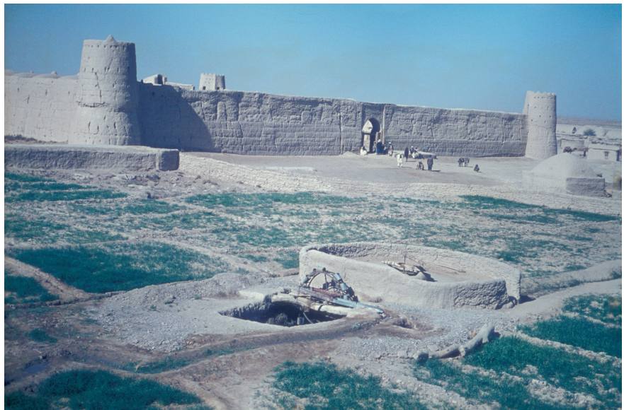
Abb. 3. Die Qala des Abdul Latif Khan in Lokhi nordöstlich von Sistan am Khashrud.
