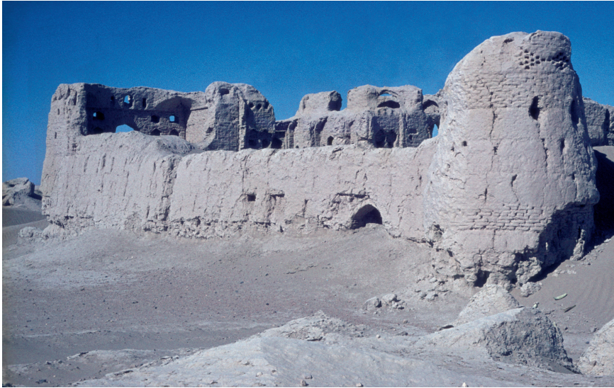
Abb. 4. Ivanhofhaus mit dem hinteren Eingang zum Hof und dem Eckturm.
