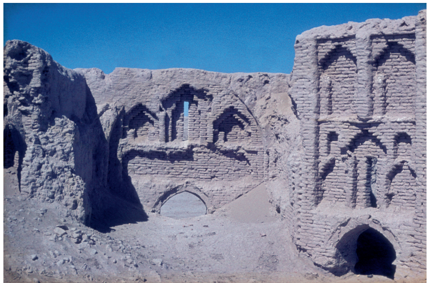
Abb. 14. Ivan mit zwei- und dreifacher Wandschichtenstaffelung bei Nishk.
