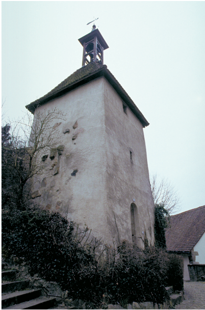
Abb. 4. Das Wasentürmchen (verm. von 1642) von Nordosten. In der Fassade sind die integrierten Reste des Megalithturms des 13. Jahrhunderts sichtbar (Foto: Kantonsarchäologie Aargau).
