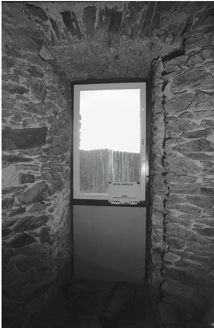
Abb. 5. Der Nebenraum im ersten Obergeschoss zeigt in der Westmauer eine größere, bodentiefe Öffnung, die von einer Bogenmauerung überdeckt wird. Auf der Innenseite dieser Öffnung verweist an beiden Laibungen je ein vertikaler Abdruck auf die ursprüngliche Existenz eines hölzernen Türrahmens.
