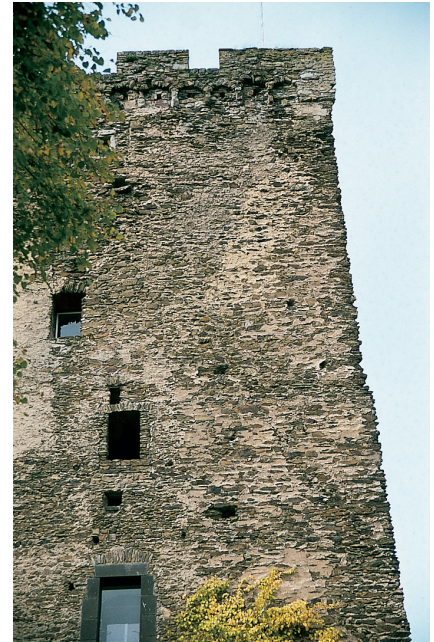
Abb. 7. Das Mauerwerk des Bergfrieds zeigt im nordöstlichen Teil der Südostfassade größere Steinformate als das Mauerwerk im südwestlichen Teil. Die wenigen erkennbaren Gerüstholzlöcher sitzen auf anderen Niveaus.
