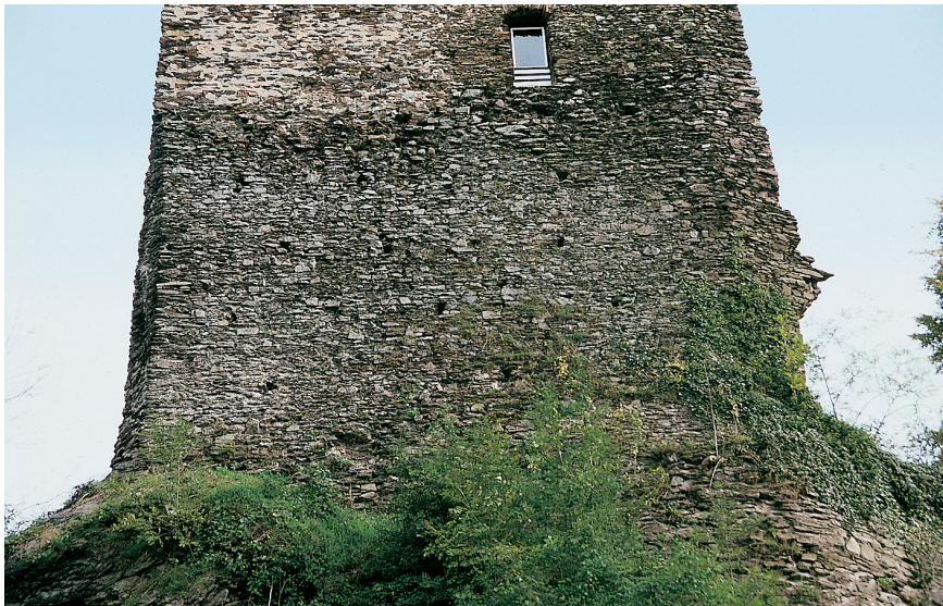
Abb. 3. An seiner Westfassade zeigt der Bergfried unterhalb eines leichten Absatzes ein kleinteiligeres Mauerwerk mit Gerüstholzlöchern in relativ gleichmäßigen Abständen.
