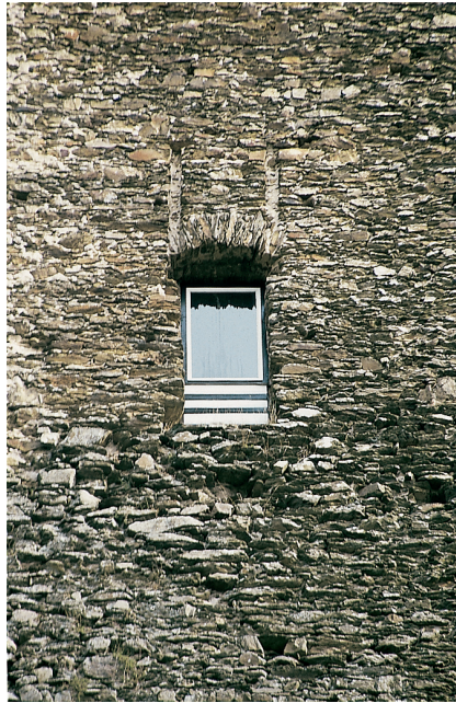
Abb. 6. Die Westfassade zeigt im ersten Obergeschoss eine relativ große Öffnung mit einer Bogenmauerung als oberem Abschluss. Beiderseits der Bogenmauerung verlaufen vertikal Nuten im Mauerwerk nach oben, die an ihren oberen Enden in das Mauerwerk hineinzuführen scheinen.
