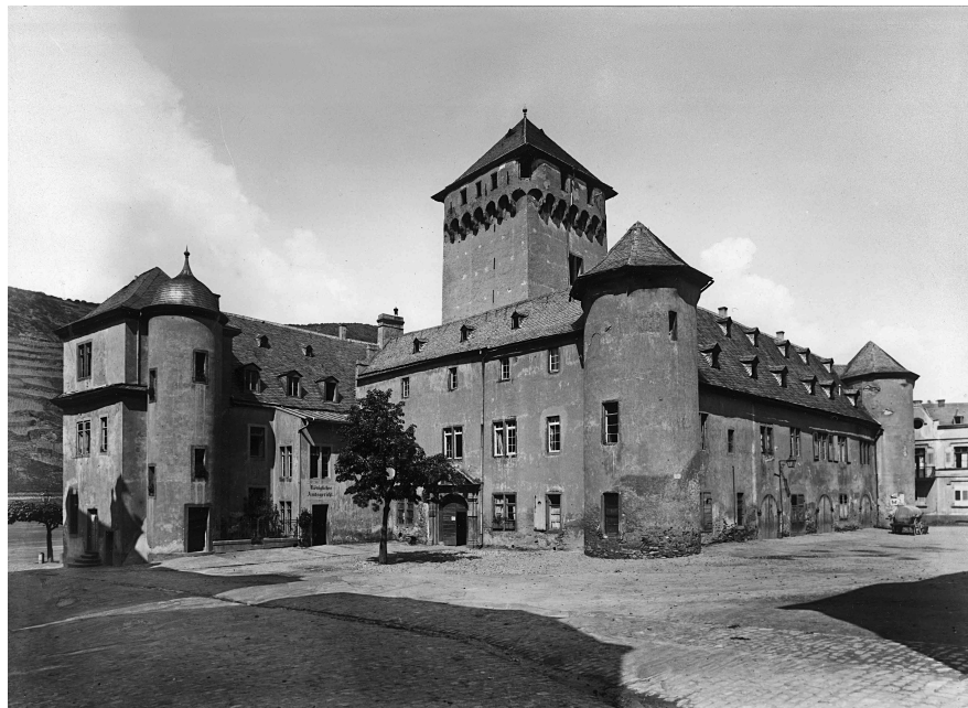
Abb. 19. Die historische Fotografie zeigt einen Blick auf die Gesamtanlage von Südwesten um das Jahr 1900 (DBV-Archiv, Europäisches Burgeninstitut, Dokumentation Boppard).
