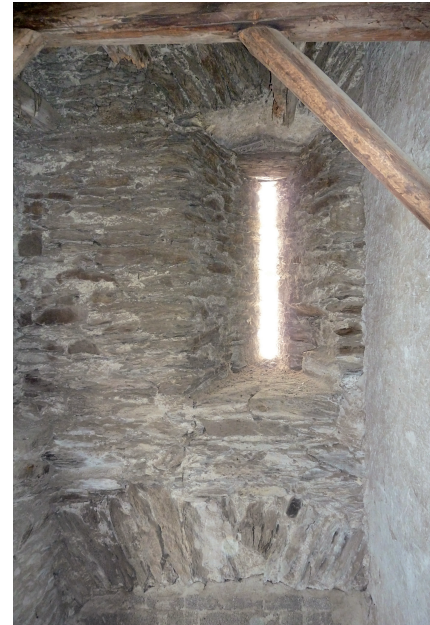
Abb. 7. Die Stadtmauer um die Oberstadt wird auf der Innenseite durch große, hohe Bogennischen gegliedert, in denen eine Schießscharte sitzt, die mit kräftigen Widerlagerhölzern für die Nutzung von Feuerwaffen versehen werden konnte (Foto: Verf.).
