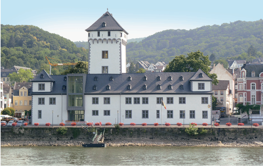
Abb. 1. Nordansicht der Kurfürstlichen Burg in Boppard nach den weitgehend abgeschlossenen Sanierungsmaßnahmen (Foto: Verf., 2015).
