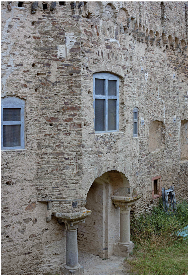
Abb. 3. Der östliche Mittelrisalit der Mantelmauer mit den beiden nachträglich untergestellten Säulen in Zweitverwendung (Foto: K. Frein).
