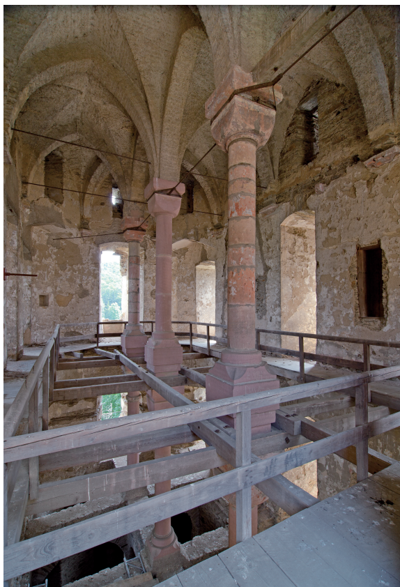
Abb. 15. Das hohe Obergeschoss im Saalbau wurde von einem Kreuzgratgewölbe überdeckt, das auf drei Säulen ruhte (Foto: K. Frein).
