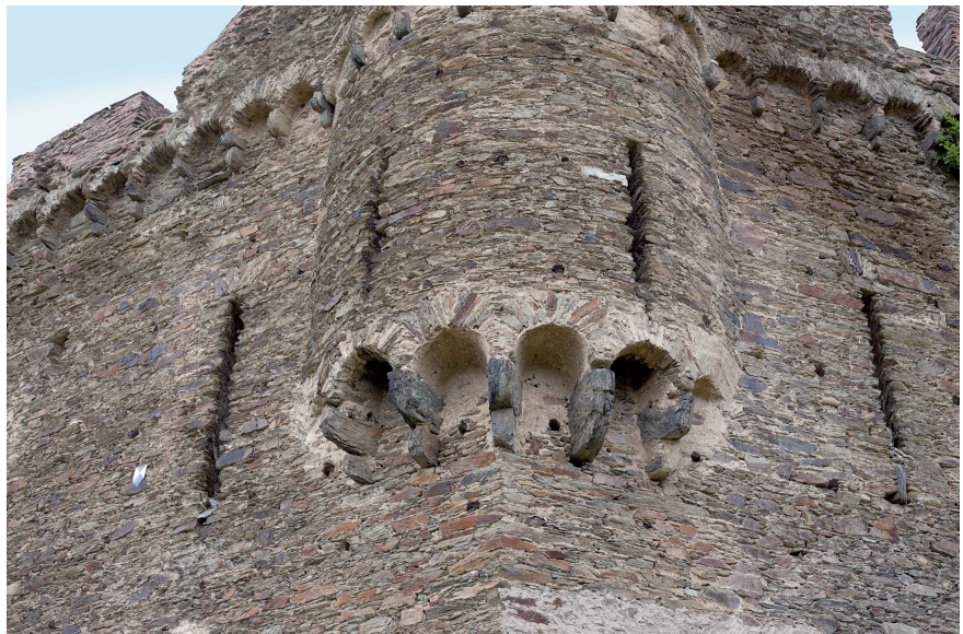
Abb. 9. Der untere Bogenfries des Türmchens an der südsüdöstlichen Außenkante der Ringmauer um den Vorhof weist zwei Wurföffnungen auf (Foto: K. Frein).
