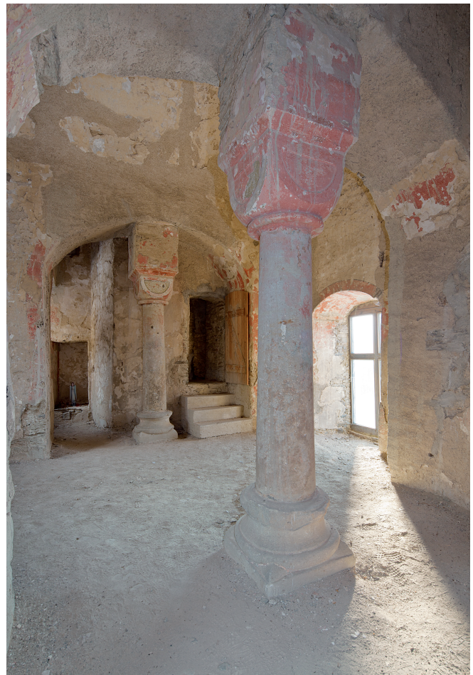
Abb. 3. Der östliche Mittelrisalit der Mantelmauer mit den beiden nachträglich untergestellten Säulen in Zweitverwendung (Foto: K. Frein).
