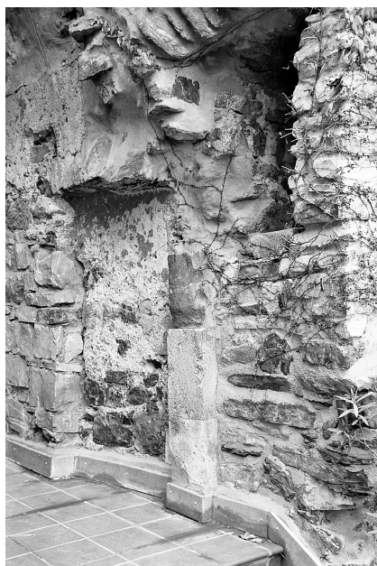
Abb. 13. An der Innenseite der Außenfassade des Ostflügels ist im ersten Obergeschoss erkennbar, dass vom ehemaligen Treppenaufgang vom Burghof je ein Zugang mit kräftigen steinernen Gewänden in die daneben liegenden Räume führte.
