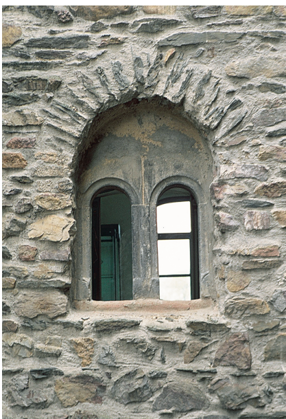
Abb. 8. Die Hoffassade des Westflügels hat im ersten Obergeschoss zwei Zwillingsfenster.
