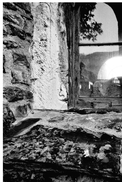
Abb. 14. Beim östlichsten Fenster in der Außenfassade des Nordflügels im zweiten Obergeschoss zeigt die einfache Fase an den Kanten der Gewändesteine am unteren Ende volutenartige Blattüberwürfe.
