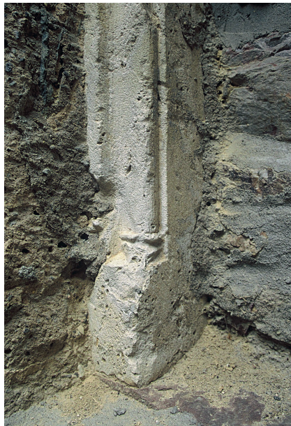
Abb. 10. Das Karniesprofil des Zwillingsfensters zeigt an den Kanten der Gewändesteine am unteren Ende Eckzehen mit darüber sitzenden Wülsten.
