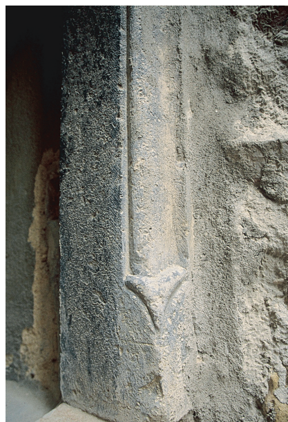
Abb. 9. Beim südlichen Zwillingsfenster in der Hoffassade des Westflügels im ersten Obergeschoss zeigt das Karniesprofil an den Kanten der Gewändesteine am unteren Ende Eckzehen.
