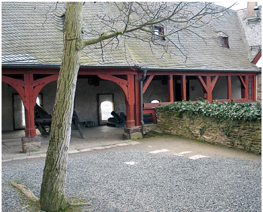
größeren Öffnungen mit Holzrahmen umgestaltet. Das Mauerwerk dieser Veränderungen besteht aus Schiefer und einem weißlich-grauen, leicht bräunlichen Mörtel mit vielen etwas größeren Zuschlagsstoffen aus Kiesel- und Tuffbruch sowie wenigen großen Kalkbröckchen. Zur selben Zeit kam es im Erdgeschoss zur Erneuerung der steinernen Trennmauer zwischen den Räumen E RP 02 und E RP 01 durch eine Fachwerk-Trennwand.
