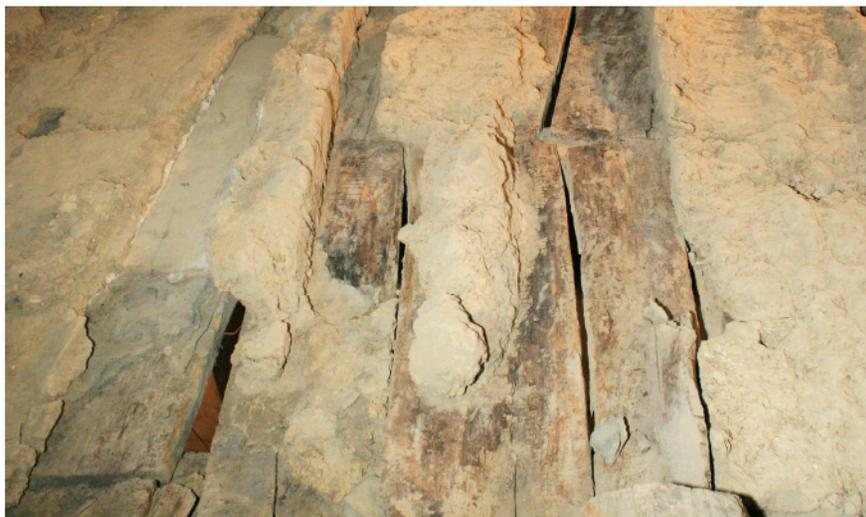
Abb. 5. Der Fußboden wird von bis zu 41 cm breiten und ca. 5 cm starken Holzdielen aus Eichenholz mit sauber bearbeiteten Oberflächen gebildet (Foto: P. Pfeiffer).
