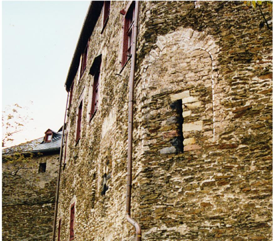
Abb. 2. Beiderseits des Knicks zwischen Nord- und Nordwestfassade sitzen im Bereich des Untergeschosses zwei größere Öffnungen mit unterschiedlichen oberen Abschlüssen (Foto: K. Schröder; DBV-Archiv).
