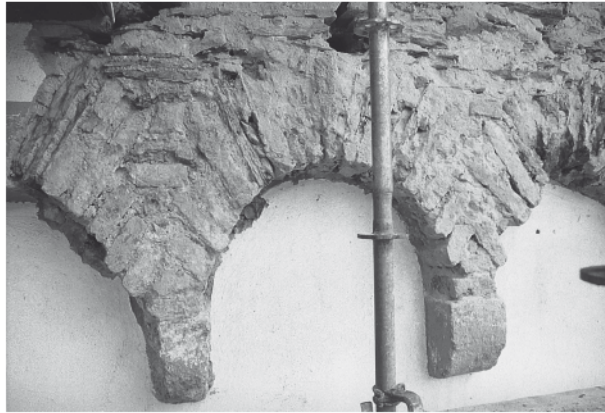
Abb. 41. Auf die beiden unteren Stockwerke der Ringmauer war ein leicht auskragender und beiderseits auf Bogenfriesen über Sandsteinkonsolen ruhender Wehrgang aufgesetzt (Foto: L. Frank).
