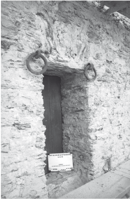
Abb. 40. Das dritte und vierte Obergeschoss des Zollturmes hatte jeweils sechs unvergitterte Fenster. Sie konnten durch Aufstellläden außen verschlossen werden. Diese Läden waren an eisernen mit eisernen Ösen im Mauerwerk beiderseits der Fenster unterhalb der Sturzplatten verankerten Ringen aufgehängt (Foto: L. Frank).
