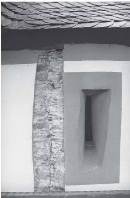
Abb. 42. Der oberste Wehrgang im zweiten Obergeschoss der Ringmauer wurde auf beiden Seiten von Brüstungsmauern gesichert. Die äußere hatte einen gleichmäßigen Wechsel von länglichen schmalen Schießscharten und Zinnenöffnungen, die nachträglich zugemauert wurden (Foto: L. Frank).
