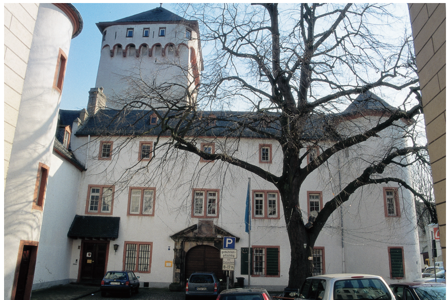
Abb. 2. Nachträglich wurde an die Westmauer des Bergfrieds ein zweigeschossiger, L-förmiger Westflügel mit einem südwestlichen Eckturm angefügt.
