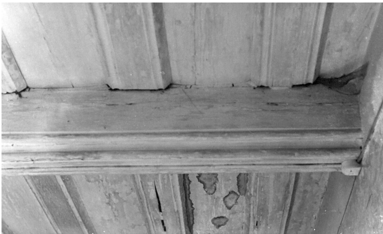
Abb. 9. Balkenbohlendecke von 1537 (Foto: Sammlung Kirchschlager, 1962).
