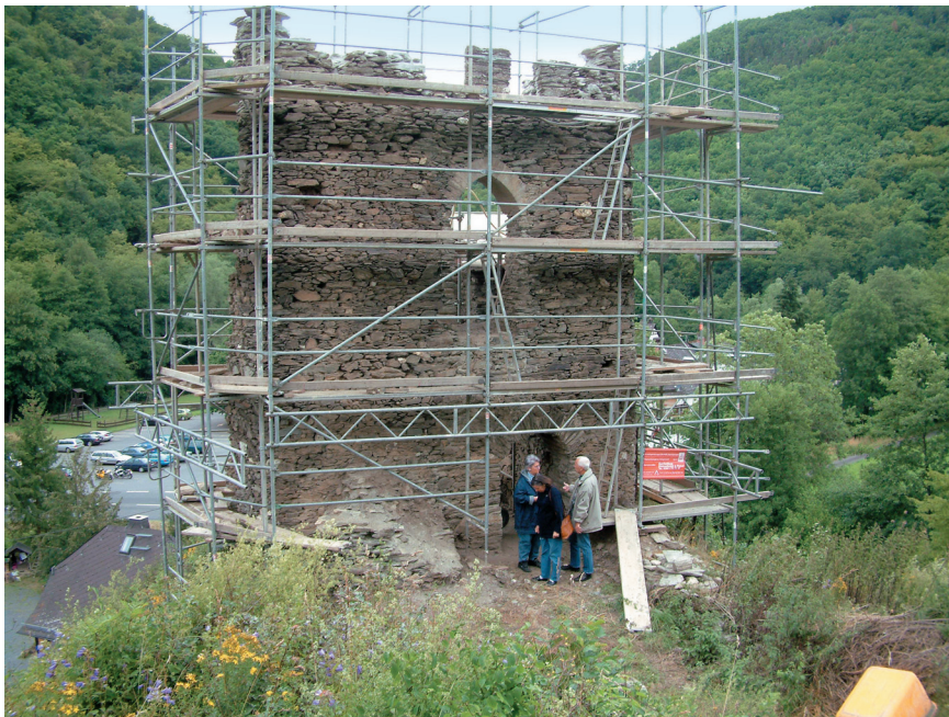
Abb. 3. Die Lauksburg im Wispertal während der Sanierung (Foto: Verf., 2004).
