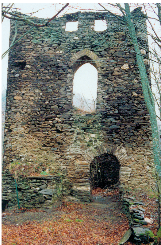
Abb. 1. Wohnturm der Lauksburg vor der baulichen Sicherung (Foto: Verf.).
