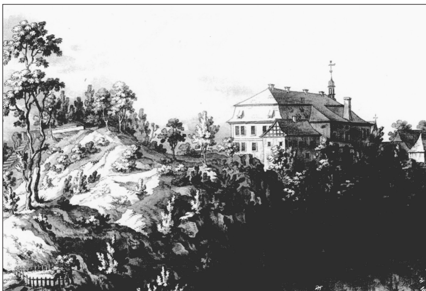
Abb. 2. Ansicht des Schlosses mit Park von Südosten, davor das sog. Försterhaus, 1774 (Oberlausitzische Bibliothek der Wissenschaften Görlitz, Schultz, Bd. 1, Nr. 42 [Ansicht des Schlosses mit Park, 1774]).
