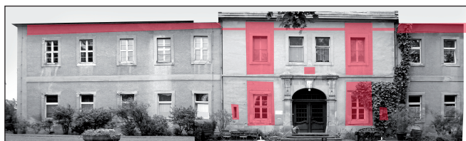
Abb. 7. Westfassade, Entwurf 6.3.1927, Plan 16236 – vermutlich der Ausführungsplan – mit Kennzeichnung der Veränderungen Eberhards gegenüber dem Bestand von 1922 (aus: DBV-Archiv, Plansammlung, Planmappe Gröditz).
