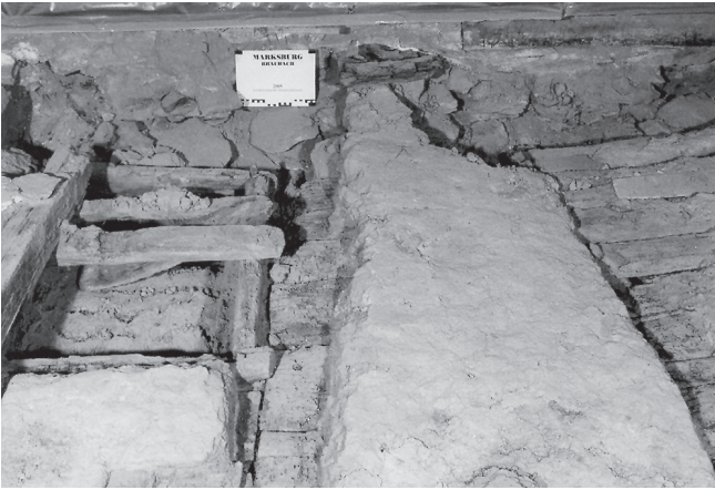
Abb. 6. Nachträglich wurde in den Dielenboden auf der Südseite etwa mittig zwischen zwei Deckenbalken eine Öffnung zwischen dem Unter- und dem Erdgeschoss eingefügt. Um diese Öffnung verschließen zu können, wurde auf die Dielen ein Rahmen aus relativ dünnen Balken aufgelegt (Foto: Verf.).
