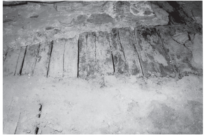
Abb. 7. In der Südwestecke des Sitzungssaales ist erkennbar, dass das Fundament für einen Kachelofen teilweise über die Dielen gezogen wurde (Foto: Verf.).
