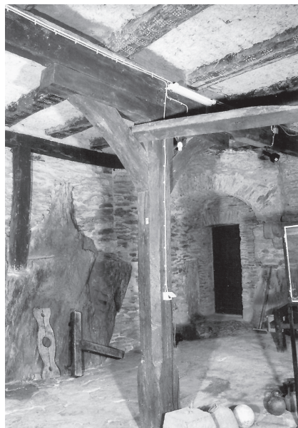
Abb. 9. Im Jahr 1777 wurden im Untergeschoss parallel zu den Außenmauern zwei Unterzüge unter den Balken eingefügt. Vermutlich gleichzeitig erhielt auch der gotische Unterzug einen mittigen Holzständer (Foto: Verf.).
