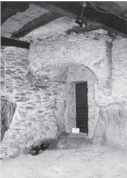
Abb. 8. Für den Einbau des Kachelofens wurden die beiden westlichen Deckenbalken an ihren südlichen Enden gekürzt und an dieser Stelle eine kräftige Bogenmauerung im Untergeschoss eingefügt (Foto: Verf.).
