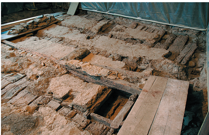
Abb. 3. In der Südostecke des Sitzungssaales ließen sich nach den Freilegungsarbeiten die bis zu 28 cm breiten und ca. 5 cm starken Holzdielen aus Eichenholz gut beobachten, obwohl die vorhandenen Estrichschichten nicht abgenommen wurden (Foto: Lutterbach).
