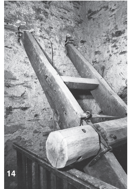
Abb. 14. Die kräftige Holzswelle der Aufzugsvorrichtung aus Holz liegt in Aussparungen der Holme und ist durch Eisenbänder gesichert. Sie zeigt einen Nagel, an dem ein Seil befestigt war, sowie an beiden Seitenenden um 90° versetzte Bohrungen für einen Drehstab (Foto: Verf., 2003).
