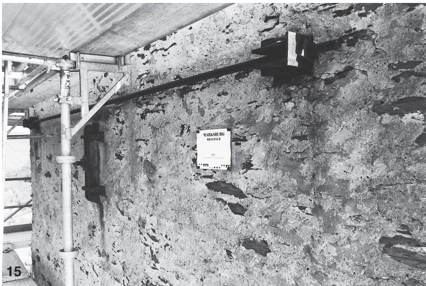
Abb. 13. Im Bereich des Bogenfrieses weist das Mauerwerk des Turmes vier eiserne Anker auf. Diese bilden an ihren Enden Ösen aus, durch die keilartige Vierkanteisen durchgesteckt sind (Foto: Verf., 2003).
