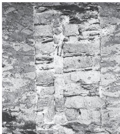
Abb. 11. Die Ostmauer zeigt im Bereich des Zugangsgeschosses eine etwas höhere und raumbreite Nische, die von einer Bogenmauerung überdeckt wird. In dieser Nische hat sich unterhalb der Bogenmauerung ein Kaminzug in der Ostmauer erhalten.
