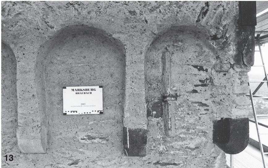
Abb. 13. Im Bereich des Bogenfrieses weist das Mauerwerk des Turmes vier eiserne Anker auf. Diese bilden an ihren Enden Ösen aus, durch die keilartige Vierkanteisen durchgesteckt sind (Foto: Verf., 2003).
