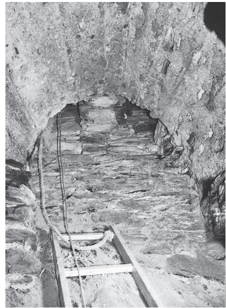
Abb. 8. Das Verliesgeschoss weist in der unteren Hälfte der Ostmauer eine ungefähr 60 cm breite und 46 cm tiefe Abortnische auf. Das Sitzbrett der Aborteinrichtung ist eine moderne Ergänzung, seine ursprüngliche Position nicht mehr genau ablesbar (Foto: Verf., 2003).
