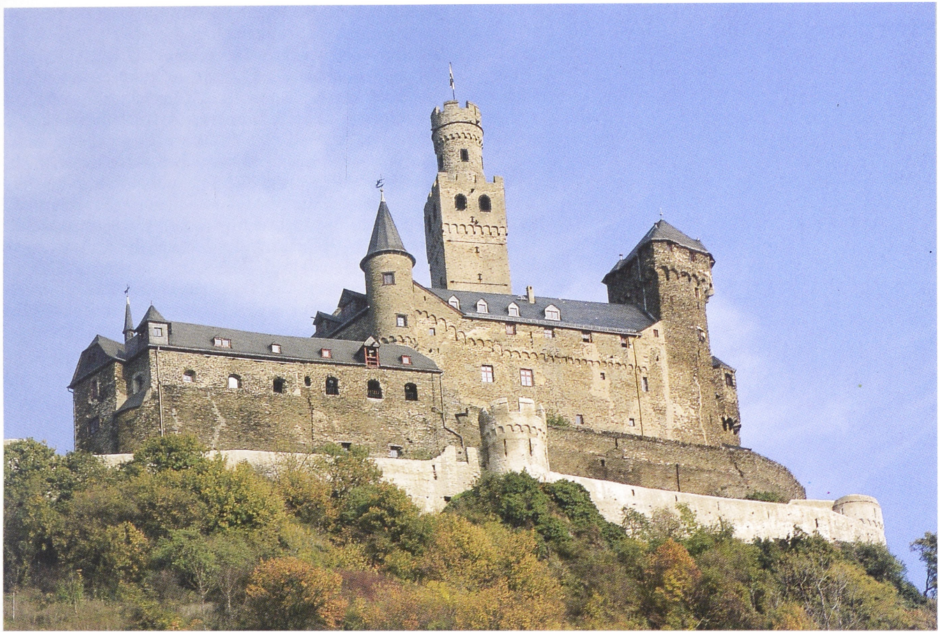
Abb. 1. Marksburg, Gesamtansicht vom Rhein. Der Kapellenturm stellt hier den rechten Abschluß der Kernburg dar (Foto: Oster).
