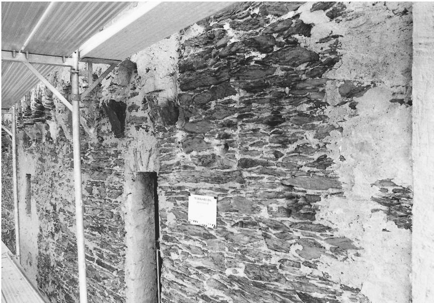
Abb. 8. Die rheinseitige Mauer der Kernburg besteht in ihrem südöstlichen Teil im Bereich des Rheinbaues und des Kapellenturms bis in eine Höhe von etwa 9,8 m über dem heutigen Niveau des Zwingers aus romanischem Mauerwerk, das ursprünglich mit einem Zinnenkranz abschloss.
