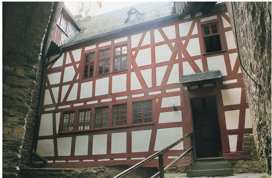
Abb. 21. Der zweigeschossige Rheinbau wurde auf der Innenseite der rheinseitigen Kernburgmauer zwischen dem Kapellenturm und dem verkürzten gotischen Nordbau eingefügt.
