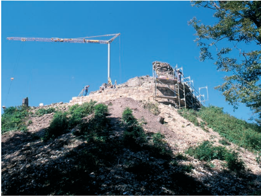
Abb. 1. Sanierung der Ringmauer im Bereich des Bergfriedes (Foto: LWL-Archäologie für Westfalen, Thomas Pogarell).
