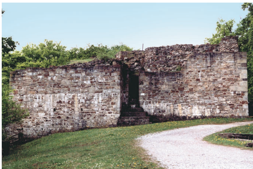
Abb. 7. Nordfront des Hauptturmssockels (z.T. wiederhergestellt).
