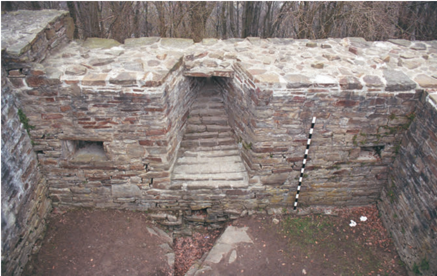
Abb. 8. Kellerraum mit Licht- und Luftschacht, Nischen und Wasserstelle in Form eines Beckens mit Überlauf (obere Mauerpartien modern ergänzt).
