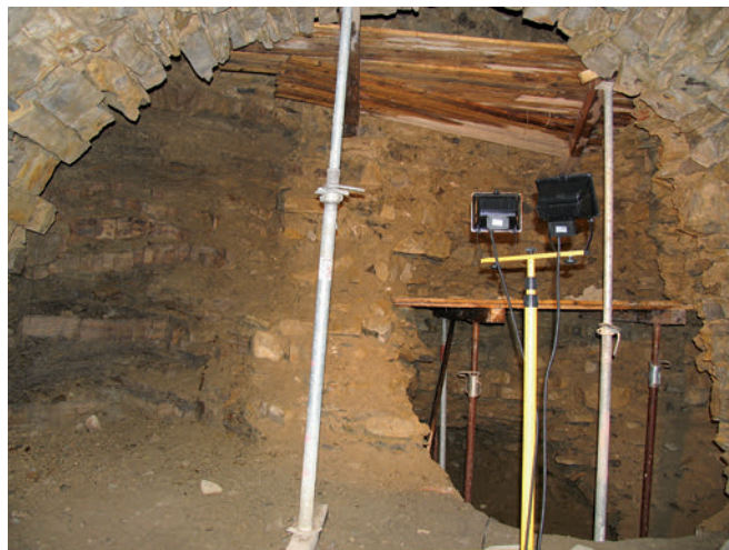
Abb. 11. Die Nordwestseite des Nordostkellers 2006. Rechts der Fels, daneben das Mauerwerk mit dem großen Hohlraum (LWL-Archäologie für Westfalen, Verf.).
