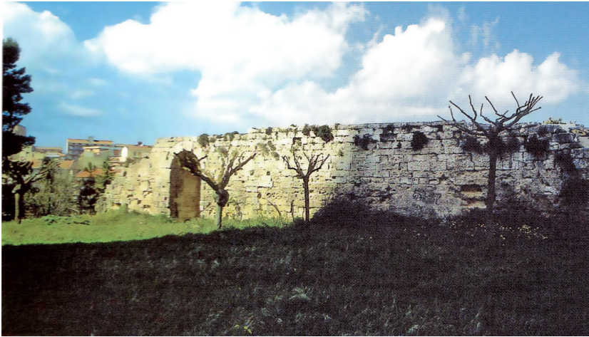
Abb. 4. Enna, Torre di Federico, Blick auf die Ausfallpforte, Ansicht von innen (Foto: Verf., 2000).
