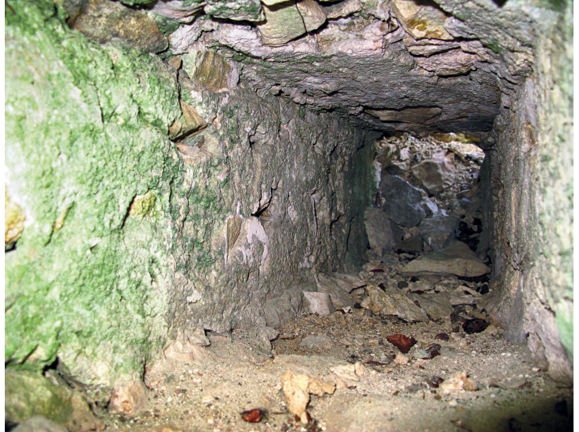
Abb. 6. Ruine Melchingen: Blick in den annähernd waagerechten „Kanal“ innerhalb der Mauer mit etwa 20/25 cm Querschnitt (Foto: Verf., 2011).
