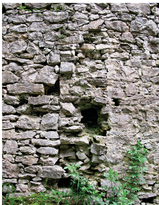
Abb. 5. Ruine Melchingen: im Rahmen der baulichen Sicherung rekonstruiertes Fenster mit einem scheinbaren Bogen über den Kanthölzern für die Zeit nach Verwitterung der Hölzer (Foto: Verf., 2013).
