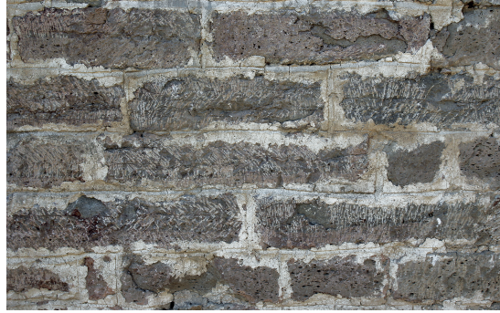
Abb. 7. Ausschnitt des Oktogonsegments (2-2); Werksteine mit in Fischgrätmuster geflächter Schauseite und Fugennetz mit feinem Fugenstrich (Foto: LWL-Archäologie für Westfalen/M. Thede).
