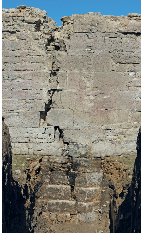
Abb. 14. Reparaturmaßnahme im Bereich eines Eckquaders der Oktogonsegmente (2-7)/(2-8) (Foto: LWL-Archäologie für Westfalen/M. Thede).
