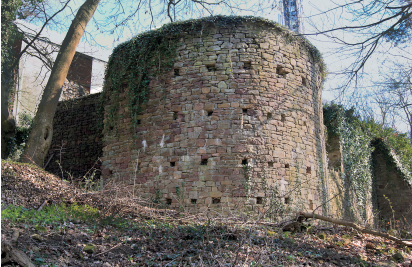
Abb. 12. Gerüstlöcher im Westturm der Burg Vlotho (um 1250) (Vlotho, Kreis Herford, NRW) (Foto: LWL-Archäologie für Westfalen/M. Thede).
