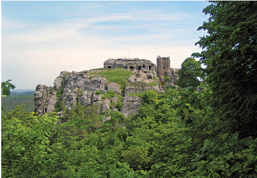
Abb. 15. Blankenburg im Harz: Burg Regenstein, mittelalterliche ausgehauene Burg auf einer Felskuppe, im 17. Jahrhundert durch einen preußischen Festungsbau überformt (Benutzer Melegros auf de.wikipedia.org unter der Lizenz CC-BY-SA-3.0-DE, Abruf am 6.7.2014 von https://commons.wikimedia ).
