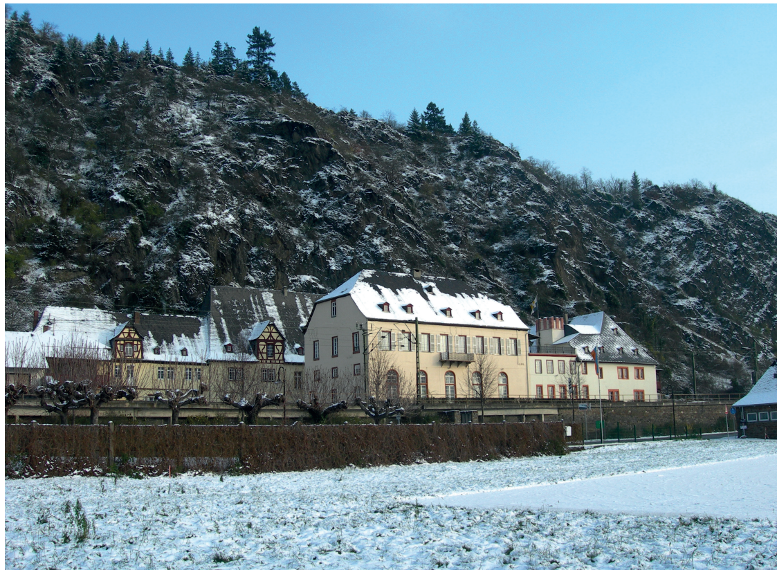
Abb. 7. Schloss Philippsburg. Gesamtansicht von Nordwesten (Foto: Verf., 2004).
