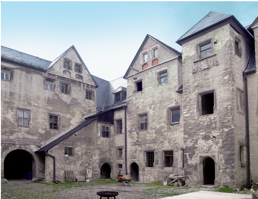
Abb. 2. Schlosshof, Blick auf West- und Nordflügel mit schmalem Anbau sowie Treppe zum ersten Obergeschoss in der Ecksituation.
