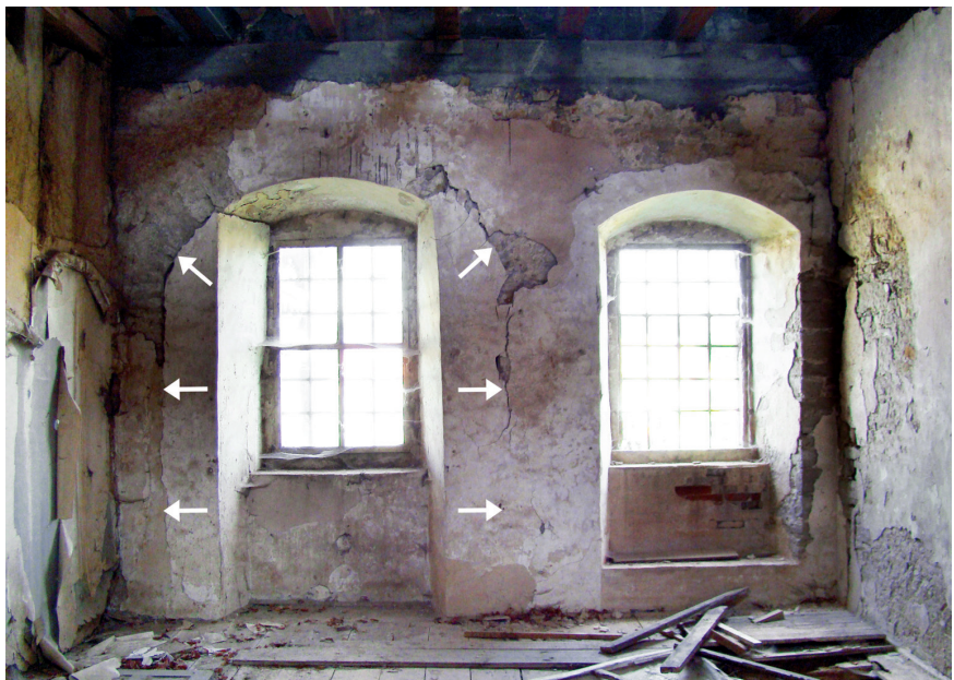
Abb. 11. Schlafkammer im ersten Obergeschoss, nördliche Außenmauer. Anstelle der rechten Fensternische befand sich im 16. Jahrhundert der Zugang zum Aborterker; die linke Nische wurde im 18. Jahrhundert verjüngt (Foto: Roland Lange, 2007).
