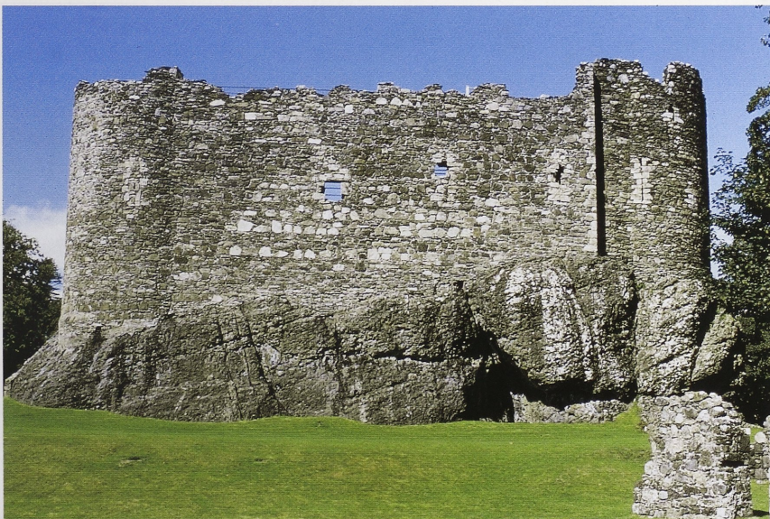
Abb. 5. Dunstaffnage Castle, Angriffsseite von Südwesten (Foto: Verf.).
