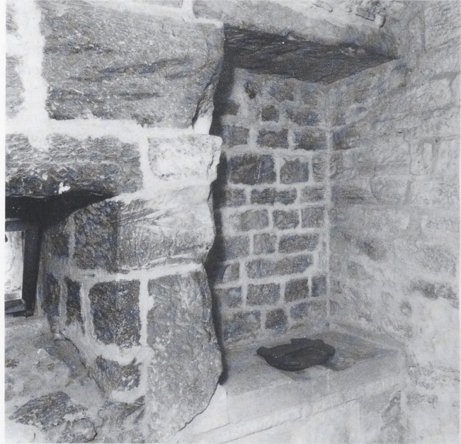
Abb. 8. Neuenburg bei Freyburg, Bergfried „Dicker Wilhelm“. Abort innerhalb der Mauerstärke im Eingangsgeschoß (Foto: Reinhard Schmitt).
