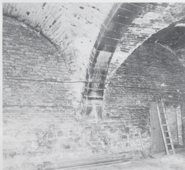
Abb. 4. Quersfurt, Fürstenhaus. Westkeller mit Blick auf die Querwand, Mauerrücksprung für die Balkendecke des ursprünglichen ersten Obergeschosses und Gewölbe mit Gurtbogen aus dem 13. Jahrhundert (Foto: Reinhard Schmitt).
