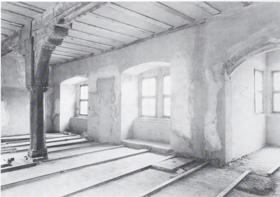
Abb. 12. Heldrungen, Schloß. „Rittersaal“ im ersten Obergeschoß des Nordflügels während der Instandsetzung (Sommer 1989) (Foto: Landesamt für Denkmalpflege Sachsen-Anhalt/Gunar Preuß).
