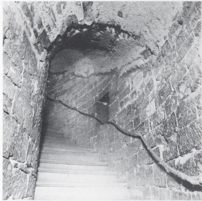
Abb. 7. Neuenburg bei Freyburg, Bergfried „Dicker Wilhelm“. Mauertreppe zwischen Eingangsgeschoß und darunter liegendem Geschoß (Foto: Reinhard Schmitt).
