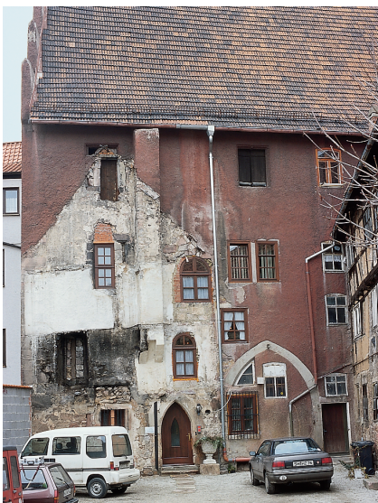
Abb. 8. Die hofseitige Traufwand der Kemenate – südliche Haushälfte. In der nördlichen Haushälfte, die durch den Anschluss des Hintergebäudes verbaut wurde, befinden sich bis heute analog ausgebildete und spiegelverkehrt angeordnete spitzböige Erschließungsöffnungen.
