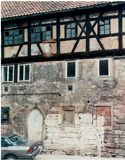
Abb. 5. Nördliches Hintergebäude, Hofwand mit einem ursprünglichen Zugang zum Keller (rechtes Portal, vgl. auch Abb. 4 „D“) und mit weiten Mauerpartien aus der zweiten Bau-phase. Das Mauerwerk besteht aus teilweise rechtwinklig behauenen großen Quadern (Wiederverwendung?) mit flachen kleinteiligen Ausgleichschichten. Das 1564 (d) nachträglich aufgesetzte Obergeschoss (siehe auch Abb. 6) erhielt zum Hof ein regelmäßig ausgestaltetes Fachwerkgefüge mit Kreuzstreben, das vom Typus dem spätmittelalterlichen Konstruktionsraster in Franken und Südthüringen entspricht. (Fotos: J. Cramer).
