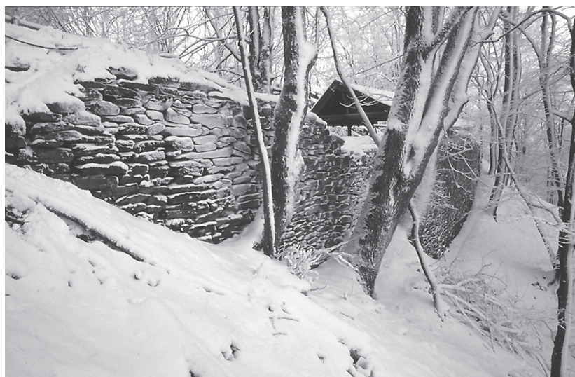
Abb. 13. Ebersberg, Ruine, südliche Vorburgmauer (Foto: Rudolph, 2005).
