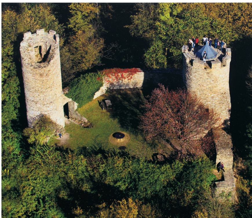
Abb. 2. Ebersburg, Ruine, Luftaufnahme (Foto: Arnulf Müller, November 2004).
