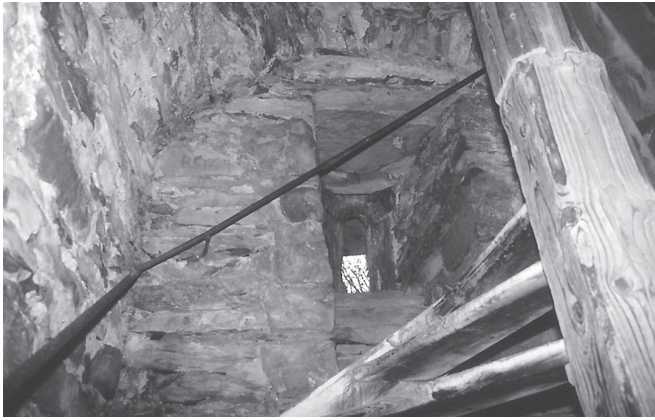
Abb. 7. Ebersburg, Ruine, Südturm, Detail: Schlitzfenster und Gewölberest (Foto: Rudolph, 2005).
