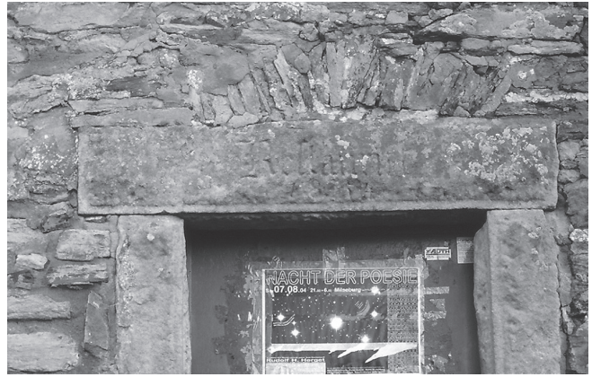
Abb. 8. Ebersburg, Ruine, Südturm, Detail. Türsturz mit Inschrift „Restaurirt 1852“ in Buckelquaderoptik (Foto: Rudolph, 2004).
