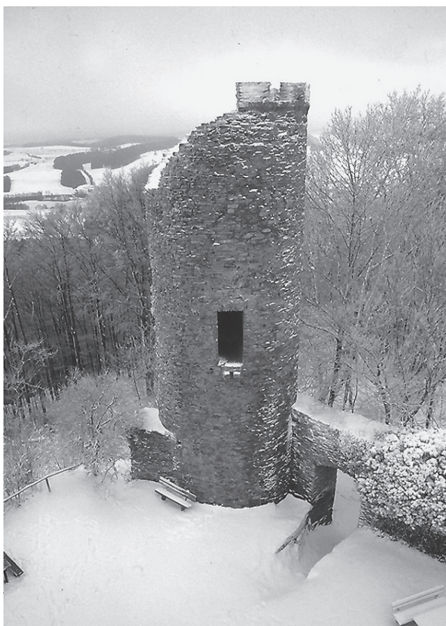
Abb. 10. Ebersburg, Ruine, Nordturm von der Wehrplatte des Südturmes aus (Foto: Rudolph, 2005).
