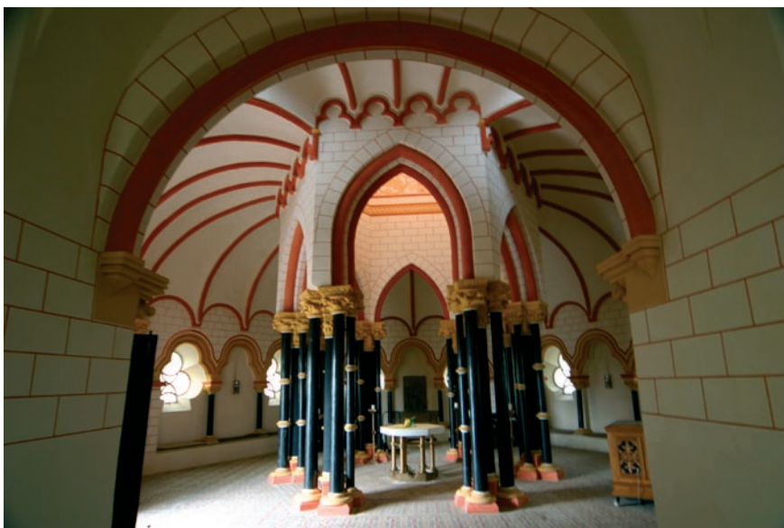
Abb. 8. Mattheuskapelle, Stützenkonstruktion nach der Restaurierung (Foto: Verf.).
