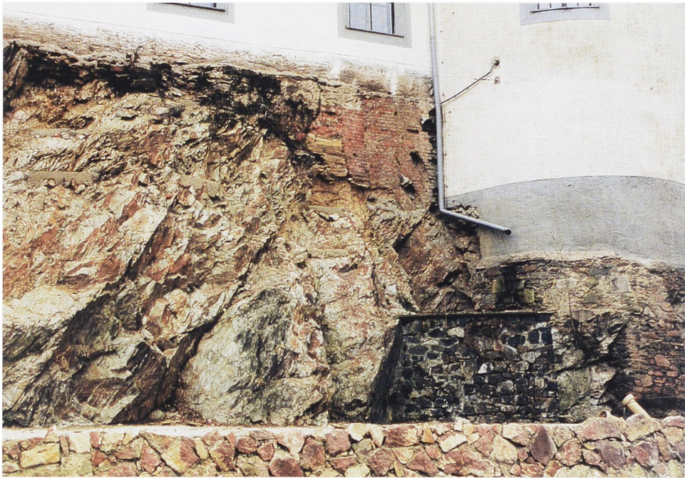
Abb. 10. Gründungsdetail an der Felswand des Westflügels von Schloß Nossen (Foto: Verf.).
