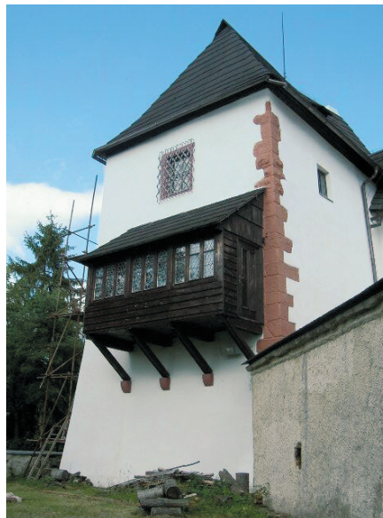
Abb. 6. Die Burg Seeberg (Ostroh), der romanische Palas.
