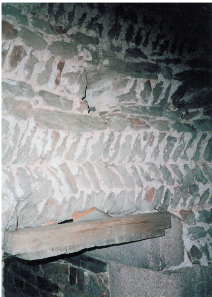
Abb. 5. Die Burg Alt-Kiensberg (Starý Hrožňatov), der Turm mit „opus spicatum“-Mauerwerk.
