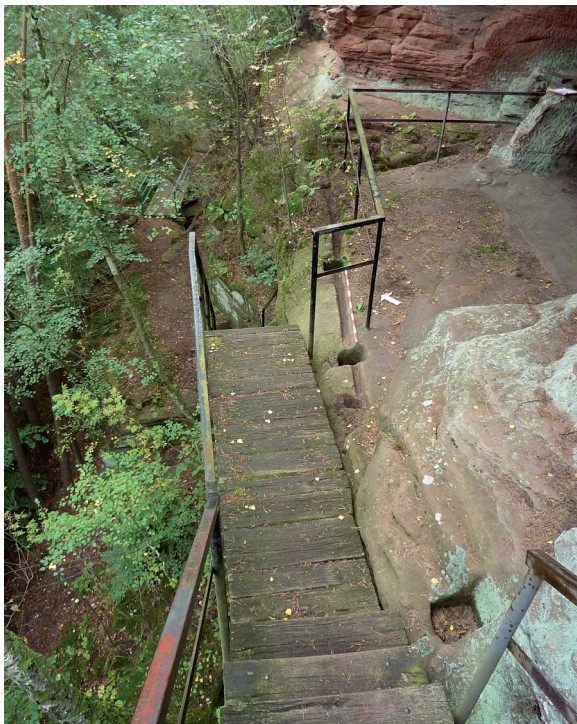
Abb. 9. Blick auf die in den Fels gearbeiteten Pfostenlöcher und Balkengrübchen im Bereich des unteren Plateaus der Felsenburg Backelstein/Hauenstein (Foto: Verf.).
