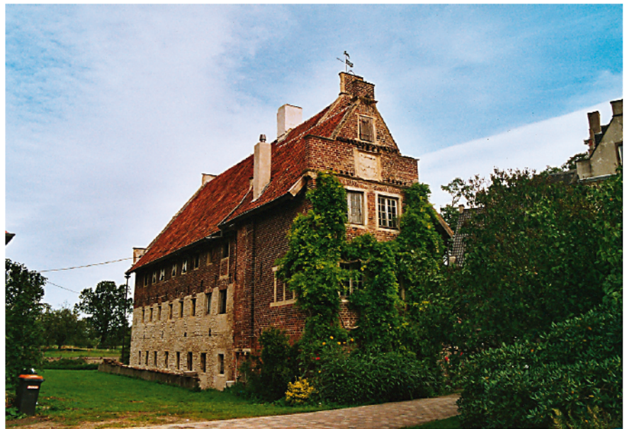
Abb. 16. Süd- und Westseite des Gebäudes nach der Außensanierung.
