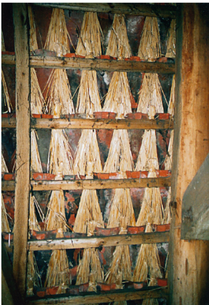
Abb. 15. Neueindeckung mit alten Hohlpfannen und Strohdocken.
