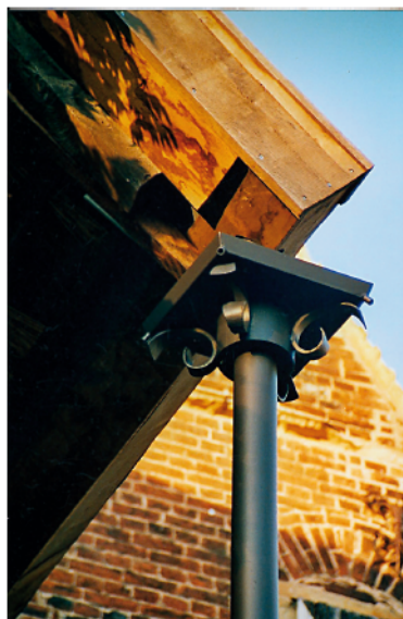
Abb. 17. Dachentwässerung: neues Fallrohr am südlichen Anbau.
