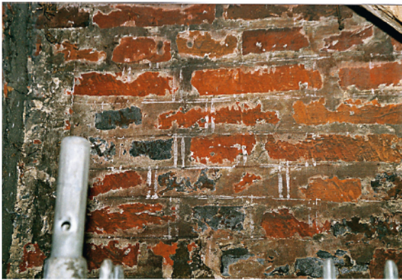
Abb. 10. Noch erhaltene rote Tünche mit Fugenstrich unter einem Vordach an der Südfassade.
