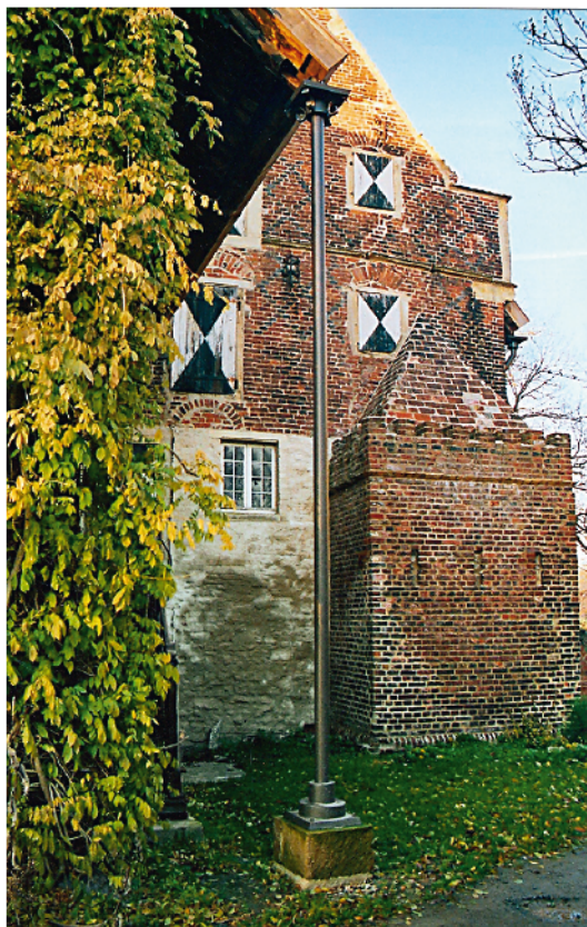
Abb. 17. Dachentwässerung: neues Fallrohr am südlichen Anbau.
