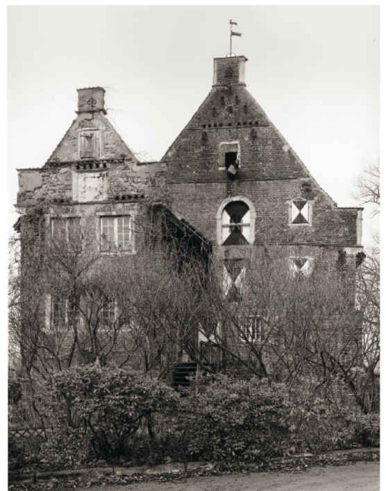
Abb. 9. Südfassade des Brauhauses vor Beginn der Arbeiten (Foto: Westfälisches Amt für Denkmalpflege).
