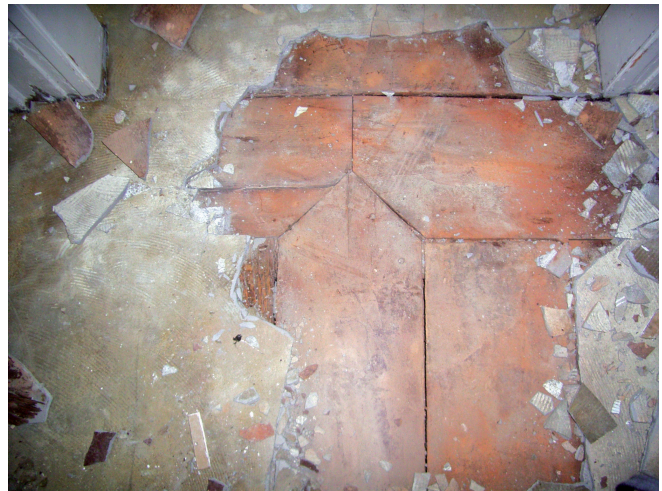
Abb. 14. Esszimmer (I.10): aufgedoppelter Boden.
