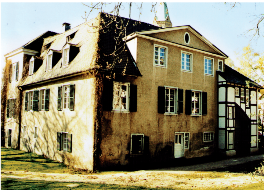
Abb. 2. Ansicht des Hauses Letmathe von Nordosten.
