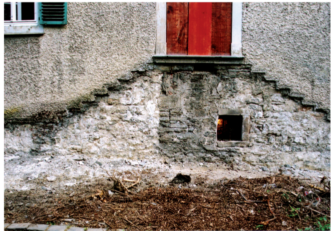
Abb. 5. Mittelalterliche Mauer mit Umbauspuren hinter der abgerissenen klassizistischen Treppe.
