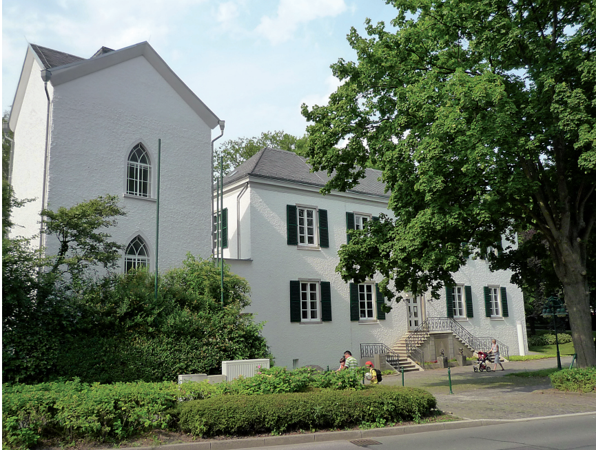
Abb. 1. Ansicht des Hauses Letmathe von Südosten nach der Sanierung.
