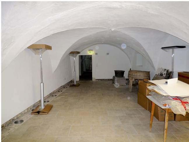
Abb. 11. Gewölbekeller mit dem 1692 ergänzten Gewölbe.
