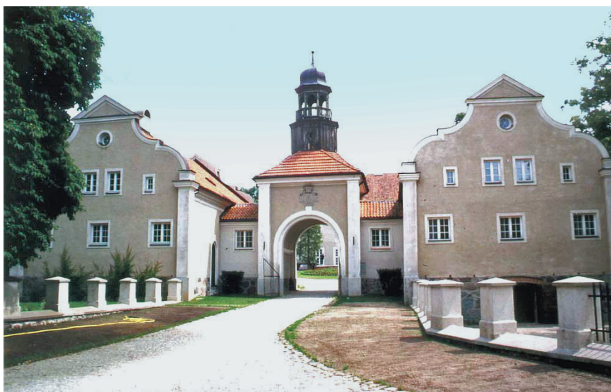
Abb. 9. Der Gutskomplex Gallingen wurde unter denkmalpflegerischen Gesichtspunkten restauriert und erstrahlt wieder in altem Glanz. (Foto: Verf.).
