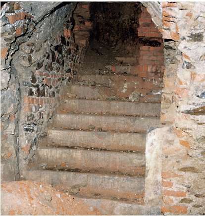
Abb. 7. Burgruine Tharandt, Treppe aus dem Tonnengewölbe unter dem Torhaus zum Hof nach Osten während der Freilegungsarbeiten. Die nördliche Treppenwange enthält Ziegelschichten (Foto: Verf., 13. 06. 92).
