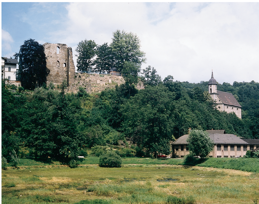
Abb. 4. Burgruine Tharandt von Süden, Zustand im Juli 1991. Rechts die Stadtkirche auf den Mauern der Unterburg, links die hohe Südwand vom „Palas“ (Torhaus von 1477) vor Beginn der Sanierungsarbeiten (Foto: Verf., 27. 07. 91).
