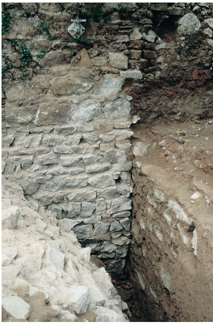
Abb. 9. Burgruine Tharandt, Mauerwinkel im Südturm zwischen Westwand (nach links) und Nordwand (nach rechts) von Südosten. An der Nordwand Reste originalen Putzes; der untere Teil der Westwand spätgotisch, der obere mit Verwendung von Ziegeln jünger. Im Vordergrund die Gewölbekappe des Tonnengewölbes im Südturm (Foto: Verf., 30. 06. 97).
