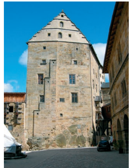
Abb. 5. Thurnau, Südansicht des Wohnturmes mit vierteiliger Abortanlage (Foto: Verf.).
