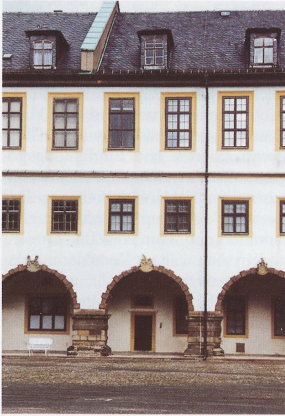
Abb. 3. Schloss Friedenstein. Sinnvolle Brandabschnittsbildung wird durch Öffnungen ohne Brandmeldung und angesteuerte Schließmechanismen der betreffenden Türen (siehe Abb. 4) nutzlos.
