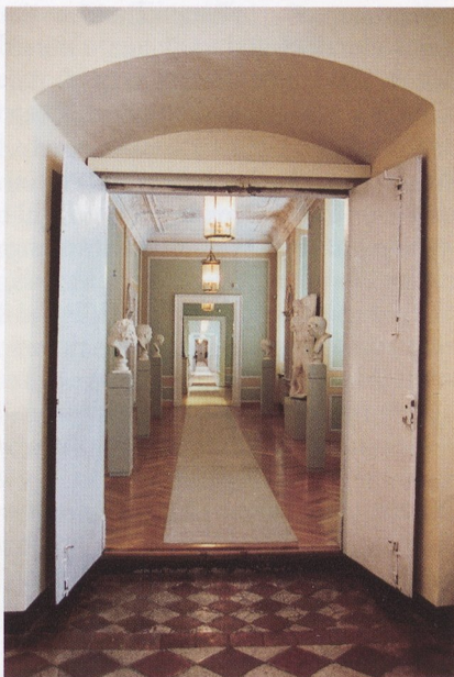
Abb. 6. Schloss Friedenstein. Bei weitläufigen Museumsbereichen sollten zumindest die Treppenraumabschluss Türen rauchdicht ausgebildet und an eine Brandmeldeanlage angeschlossen werden.
