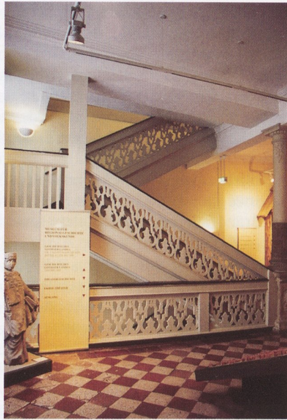
Abb. 5. Schloss Friedenstein. Historisches Treppenhaus als Fluchtweg eigentlich kein Problem, jedoch ohne jede mechanische Entrauchung im Brandfall eine hochgradige Gefährdung von Besuchern und Personal.
