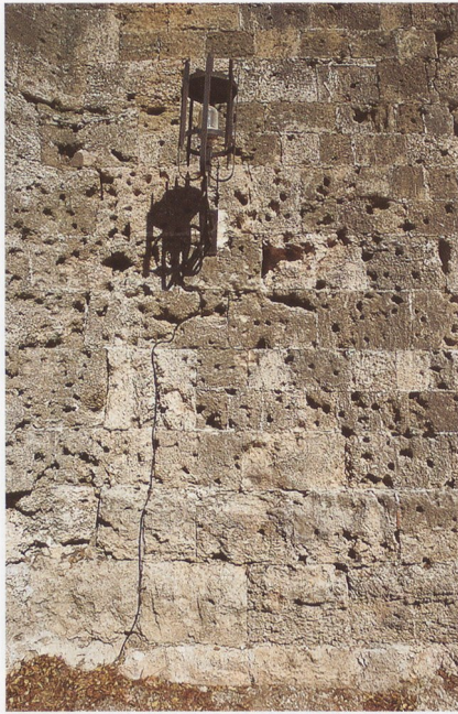
Abb. 1. Massierungen von Einschusslöchern kleinerer Kaliber in der Contrescarpe der Nordwestecke der Stadtbefestigung (Foto: Verf. 2002).
